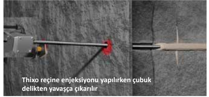
Enjeksiyon çubuğu deliğin sonuna kadar sokulur ve Thixo reçine enjeksiyonuna başlanır
