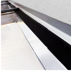
■ Duvar Profili Üst Conta Detayı Wall Profile Upper Gasket Detail
