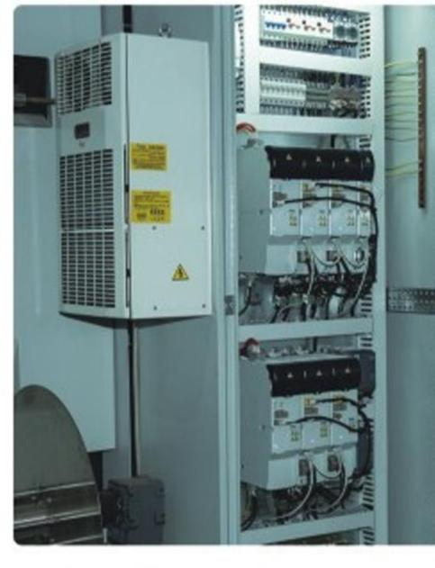
设备电柜控制箱均搭配有独立空调散热降温,有效降低能耗,延长电器寿命。
