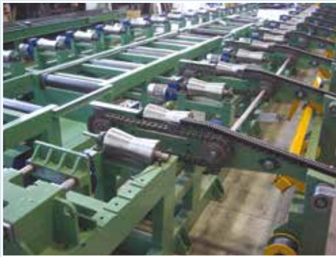
Panoramica dell'impianto View of the plant
