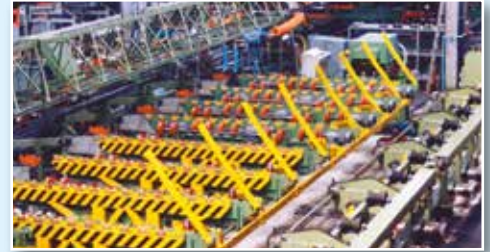
Panoramica dell'impianto View of the plant
