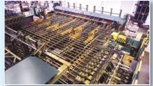
Panoramica dell'impianto View of the plant
