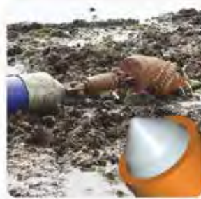
7 - Yatay yönlü delme HDD
